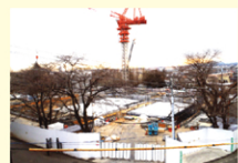
八王子キャンパスで工事が進む総合教育棟
