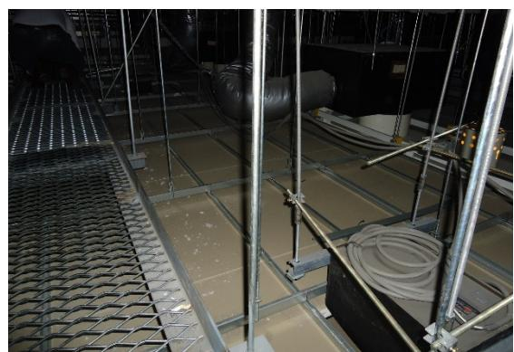
図 4 天井内部の例
