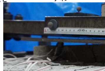
(c) アンカーボルト破断
