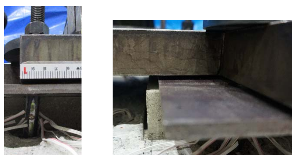
(a) アンカーボルトの傾き (b) スライディングパッドのずれ
