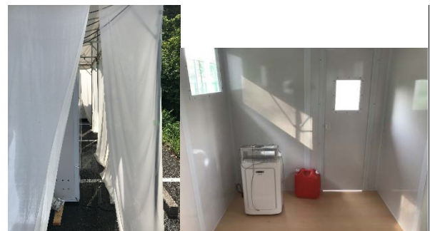
Fig.2(a)水膜設置状況
