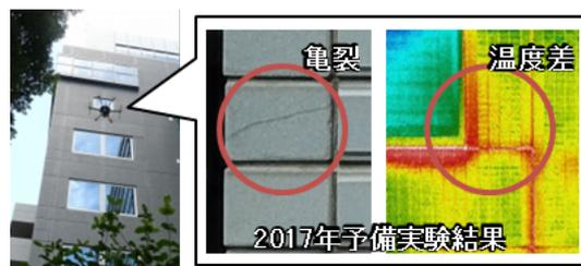
図6 飛行ドローンにより撮影した画像例
