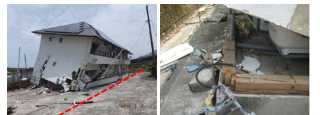
図 27 断層直上の倒壊した古い 3 階建て木造建物の倒壊。1 階は剛性の低い駐車場で、金物もないため強い揺れで柱が抜けて倒壊したと思われる
