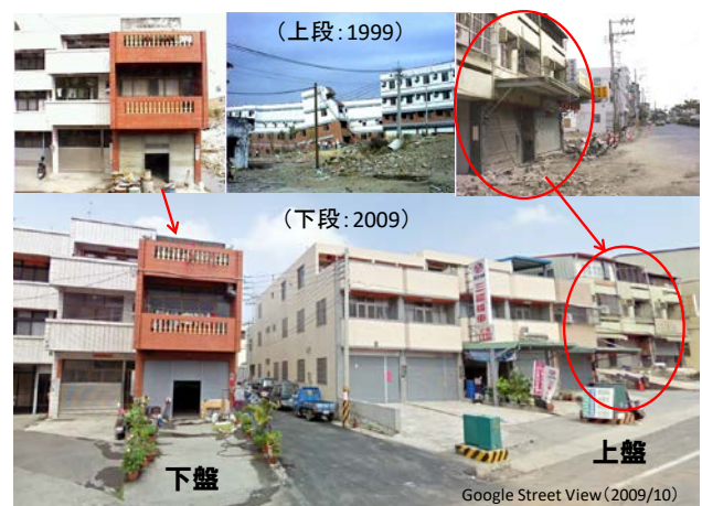
図 3 図 2 の○部分の断層変位と建物被害の状況（上段：久田撮影）と 10 年後の状況（2009 年 Google Street View、 https://goo.gl/maps/q19XaHyDD7fEFBTeA ）
