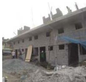
a) コンクリートブロック造の建設中の様子
