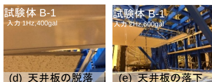
図 25 各試験体損傷状況
