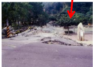
図5 豊原市中正公園近傍の主断層（左側）と上盤側の分岐した断層群 4) 。左写真は上図○部分のback thrust断層 6) 。
