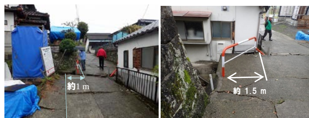
図 23 1～1.5 m の横ずれ断層変位と、その近傍の木造建物の様子（久田ほか、2019）
