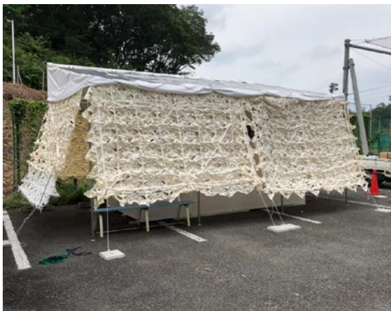
Fig.10 ER ユニットへのフラクタル日よけの設置
