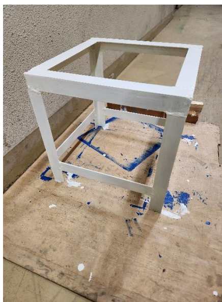
図 5 溶接によるイスの制作（途中）
