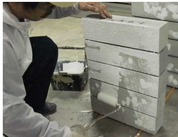
写真 5-2 ローラによる仕上材の施工風景
