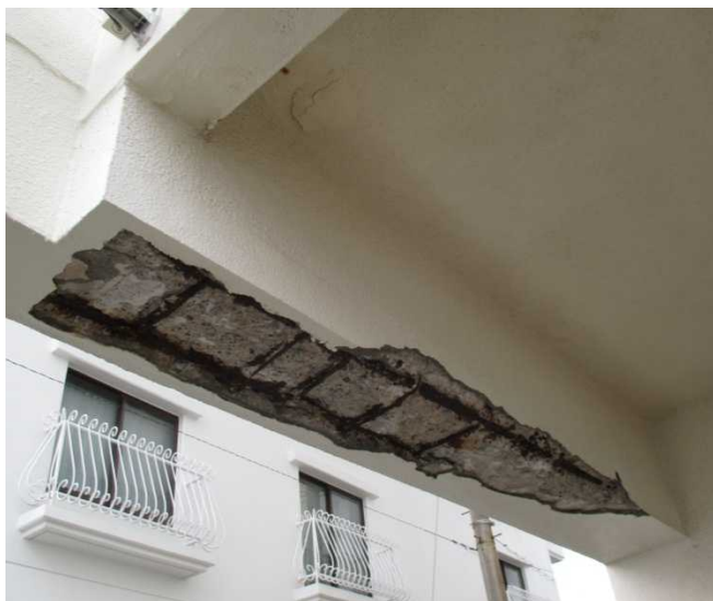
写真 1-2 塩害による劣化事例(神奈川県)
