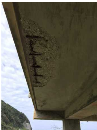
写真 1-1 塩害による劣化事例(沖縄県)
