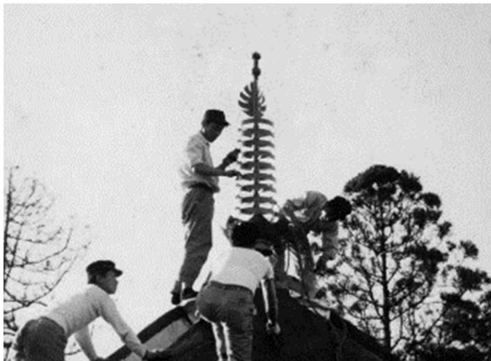
写真 2-10 九輪塔取付け
