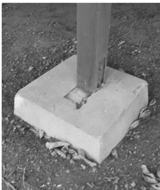
写真 3-4 「辻別邸」南側テラスの床束と束石（拡大）
