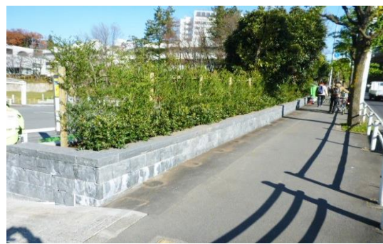
工事後のかすみ学園通り（歩道が拡幅された）
