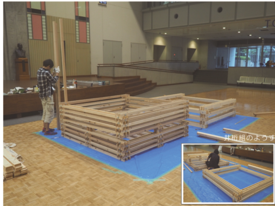
その1 構造部となる横架材を3枚で1セットとし、井桁状に組み。 部材一本は軽く、ボルトがガイドとなり容易に組み立て出来る。
