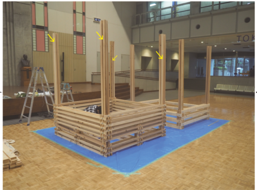
その2 井桁状に組み立てたものに柱を通す。 柱は4本1組で、1ユニットあたり16。こちらも軽く容易に作業。
