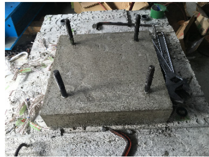
図 15 モルタルの表面
