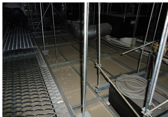
図 4 天井内部の例
