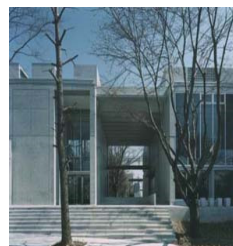
a) 工学院大学八王子校舎 15 号館
