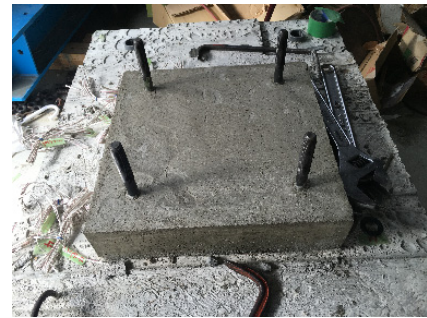
図 15 モルタルの表面
