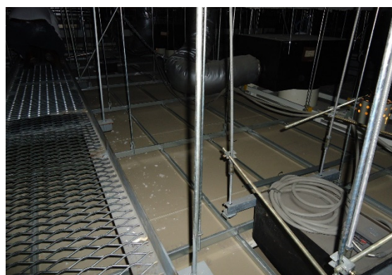
図 4 天井内部の例
