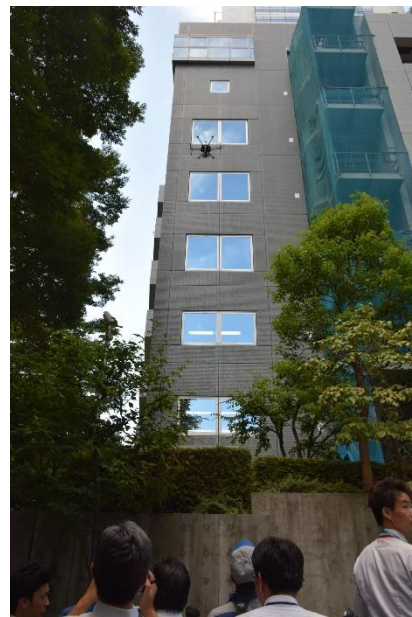
ドローンによる高層ビル外壁調査の様子(9/8 実施)
