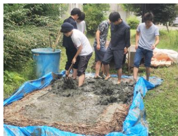
塗り壁用の土の練り返し作業
