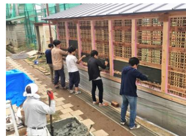
塗り壁の下塗り作業を行う様子
