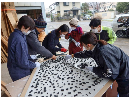
茶室内部の天井材に炭を張り付け
