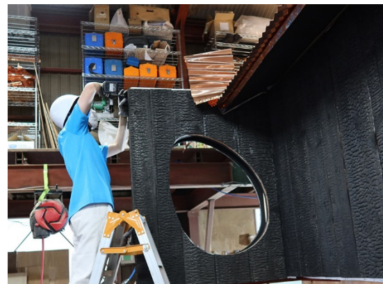
外装材の焼杉の加工・取り付け
