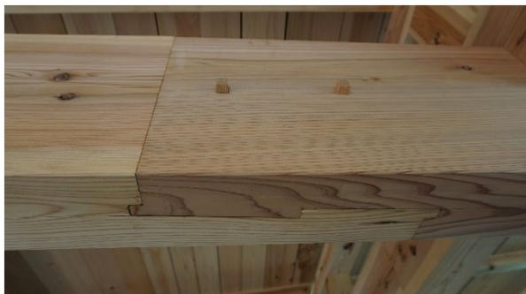
釘を使わず立体的な凹凸で継ぎ、一体化させる
