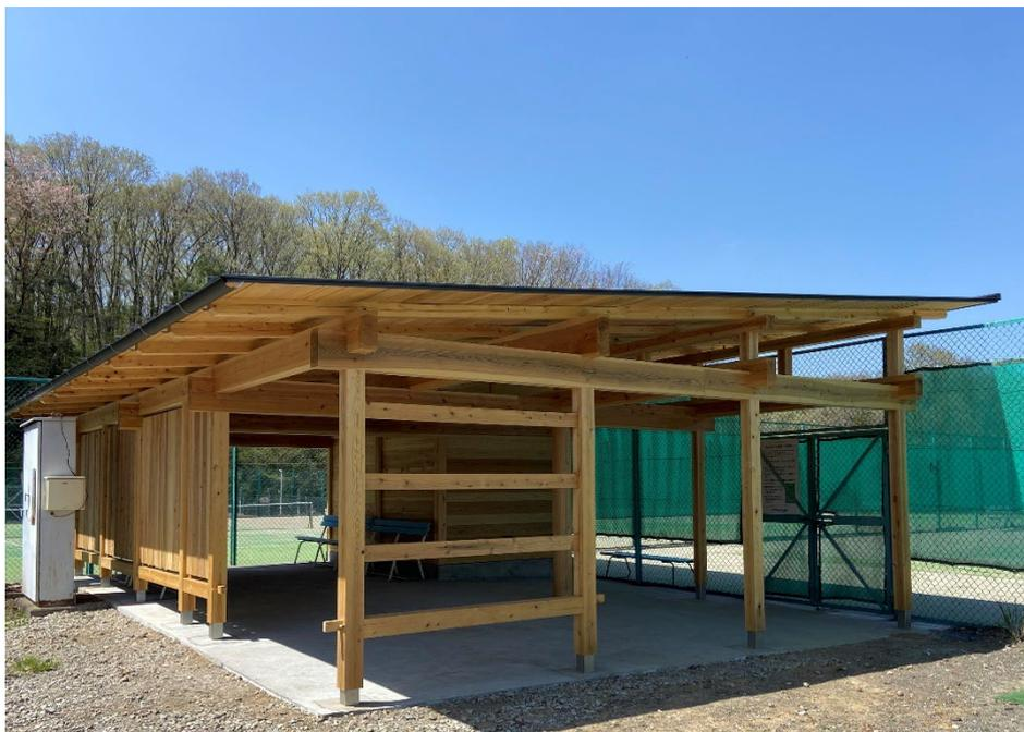
建築学部の1-2年生を中心としたグループWA-K.pro「K×Kプロジェクト」は、八王子キャンパス内に点在する老朽化した倉庫を地元多摩産の木材を使用した木造建築に建て替える活動を続けています。今回完成したレストハウスは4棟目です。
