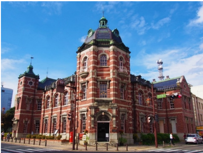
建築学科田村研究室が再生に携わった岩手銀行赤レンガ館
