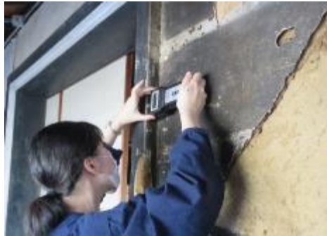
土壁修復の様子
