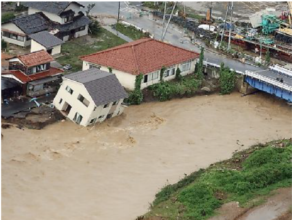
川岸が削られて傾いた建物＝2024年9月22日、石川県珠洲市の若山川、本社機から
