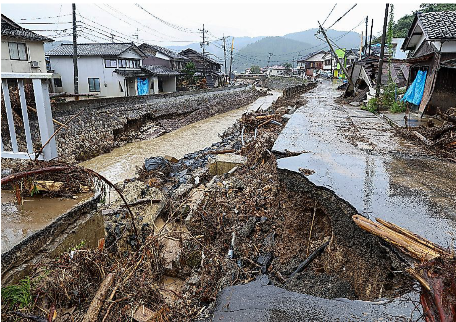
氾濫した町野川支流の鈴屋川。岸に沿って黒い大型土囊が見える。2024年10月3日、石川県輪島市
