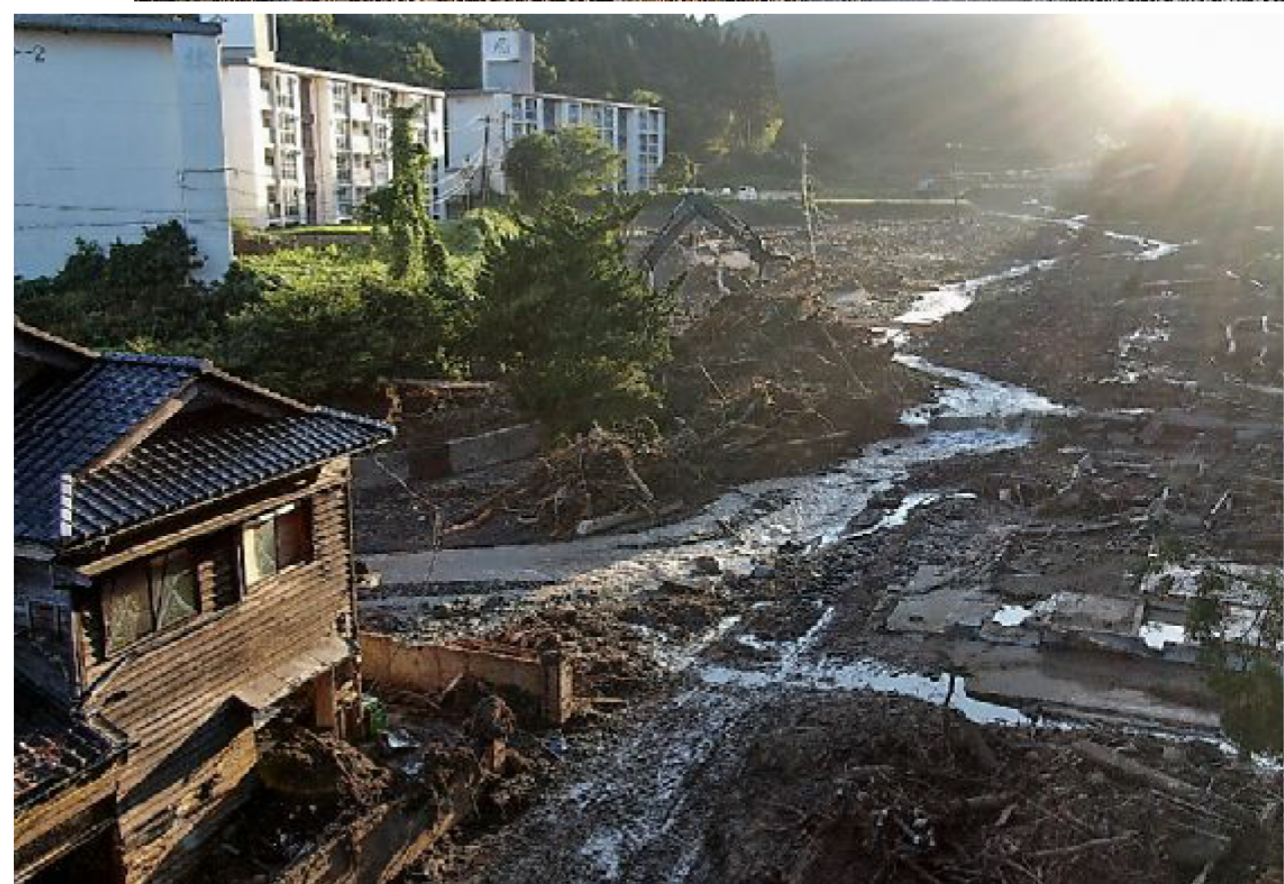
豪雨で建物が流失した現場(手前)。残った建物のそばにはコンクリート製の塀が見える。2024年9月25日、輪島市の塚田川、ドローンで撮影
