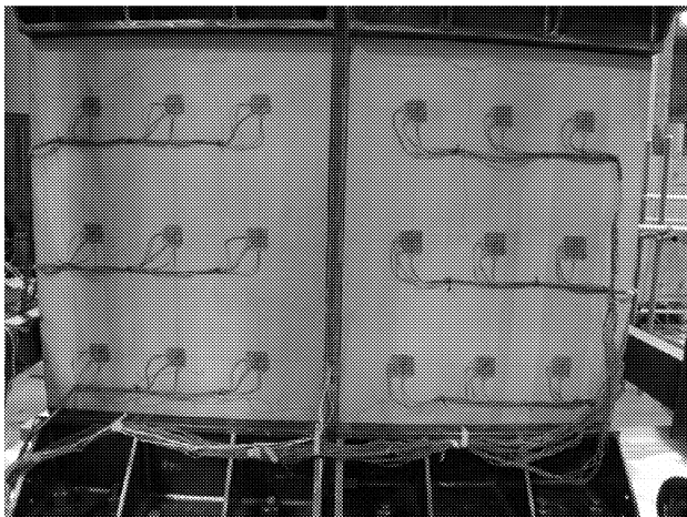
写真 3 試験体設置状況
