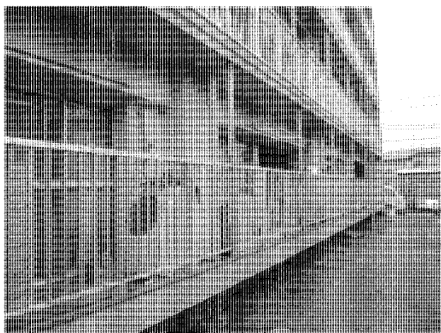
写真7 川口市耐火住宅枠内付け増し厚補強
