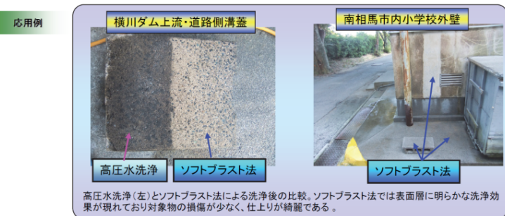
高圧水洗浄(左)とソフトプラスト法による洗浄後の比較。ソフトプラスト法では表面層に明らかな洗浄効果が現れており対象物の損傷が少なく、仕上がりが綺麗である。
