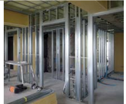
写真2 マンションに多用される軽量鉄骨下地間仕切り壁
