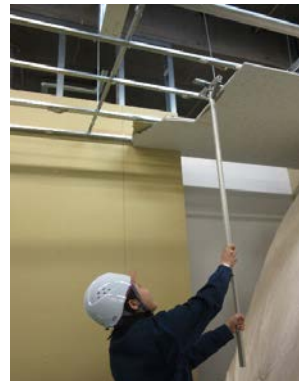
写真3 静かに、安全に脱離する軽量鉄骨下地間仕切り壁
