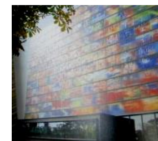
d) 廃古紙を利用した建材外壁と内装建具 図2 廃古紙の資源循環と利活用の現状
