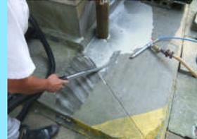
掃除機による洗浄液の回収:
