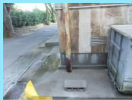
除染終了後:ソフトブラスト法による処理は対象物の損傷が少なく、仕上がりが綺麗である。
