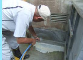
ブラスト処理中:キサンタンガムによるチキントロピー性により洗浄液の拡散が少ない。
