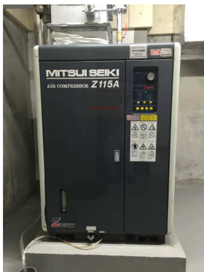
29. 三井精機製スクリーコンプレッサー 型式: Z115A 吐出量( \text{m}^3/\text{min} ): 1.6 台数: 1
